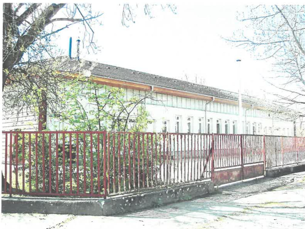
4.sz. kép: konyha északi homlokzat
