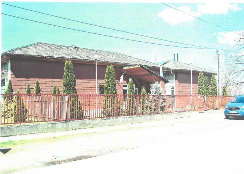
2.sz. kép: utcai homlokzat
